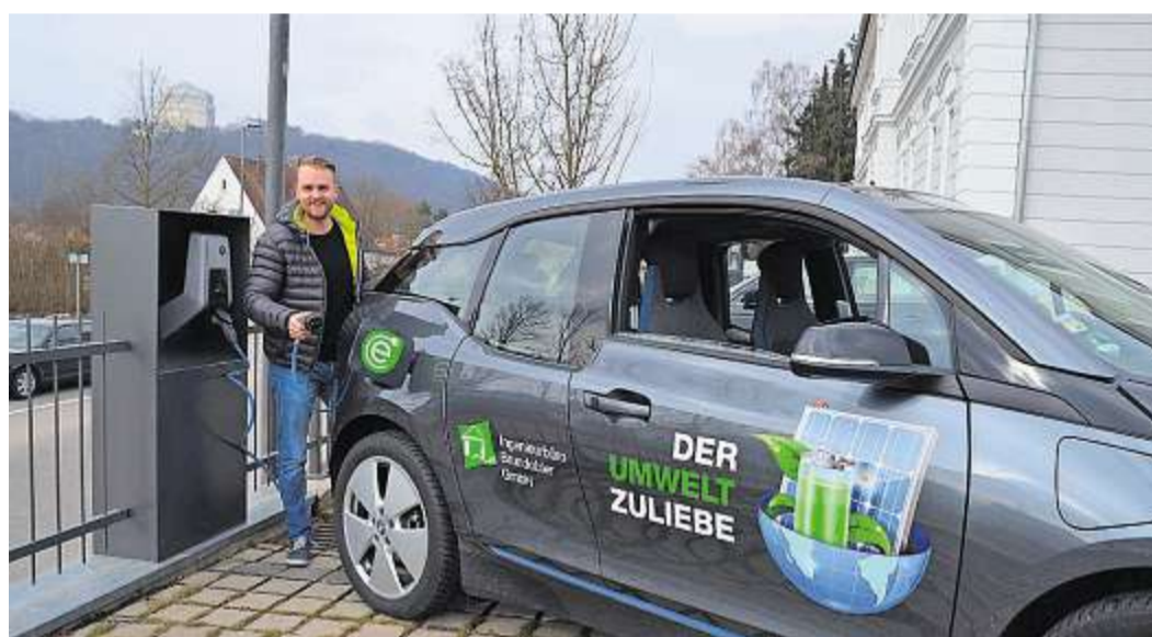
Mitarbeiter Rudi Schedl fährt den I3 sehr gern. Nach jeder Fahrt kommt das Elektromobil sofort wieder an die Ladesäule, die mittels einer maßangefertigten Metallstiele harmonisch in den Zaun eingefügt ist.
