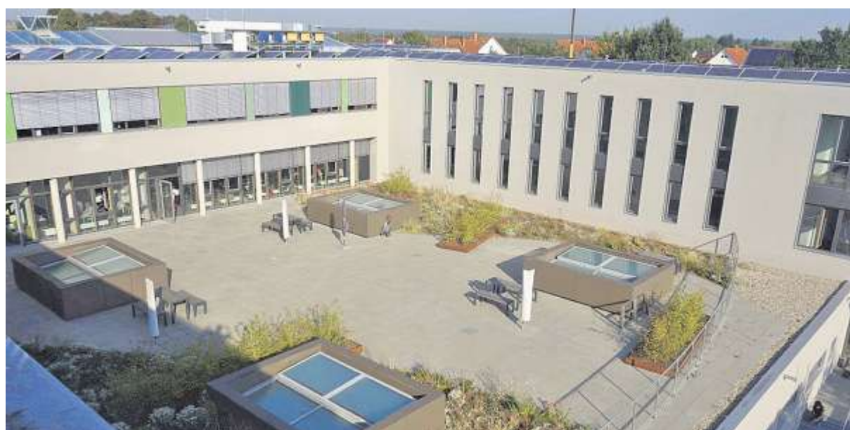
Die Planung der Gebäudetechnik für die Realschule in Großostheim war eine spannende Herausforderung für die Mitarbeiter des Wackersdorfer Büros der Ingenieurbüro Brundobler GmbH.
